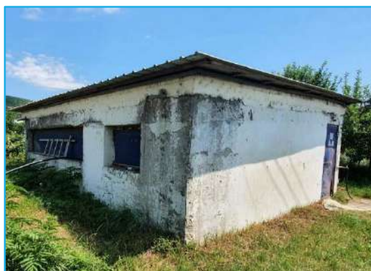
Foto nga Rehabilitimi i Stacionit të pompave në Rahovec 2
