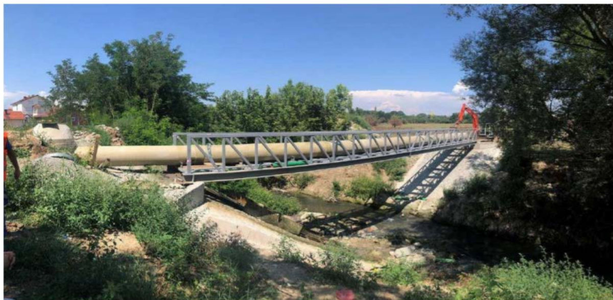
Foto 1. Gypi GRP i instaluar ne urën e tubacionit 1
